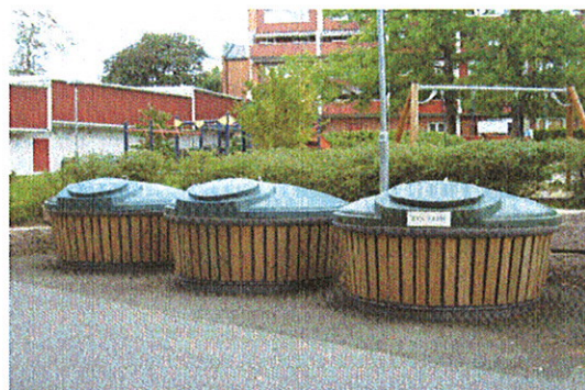
AVFALLSBRØNNER – VELLYKKET ERSTATNING FOR CONTAINERE
